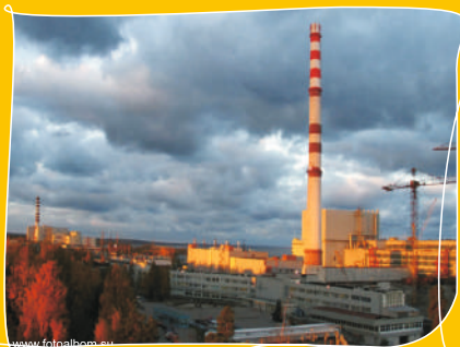
Ленинградская АЭС, г. Сосновый Бор
